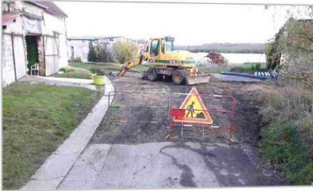
Terrassement, captage de la source et consolidation par une purge de l'argile.
